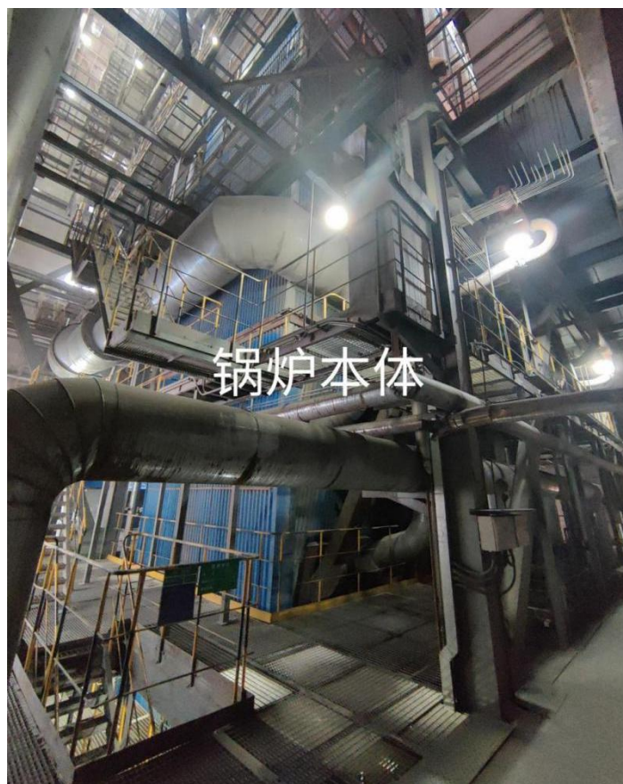
图 4-5 流化床锅炉现场图
